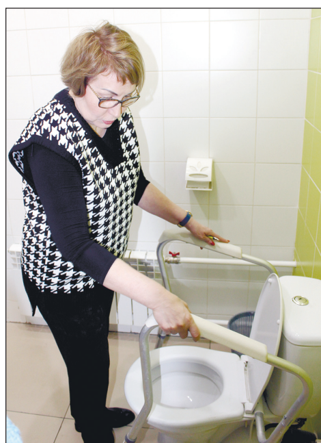
Л.А. Захарова объясняет причину недопустимости подобных креплений в туалетах.
